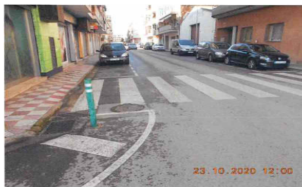
Foto nº 8. Av. Extremadura. Punt final de l'obra.
