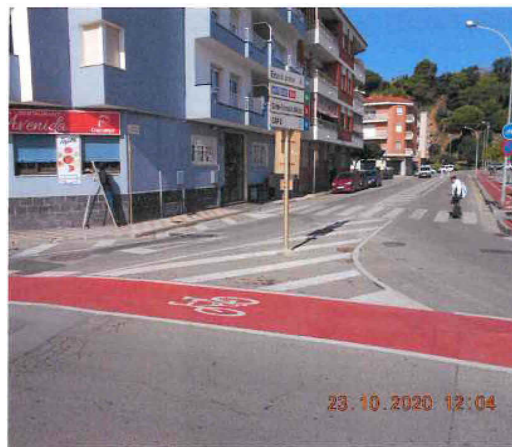
Foto nº 1. Carrer La Plantera. Punt d'inici de l'obra i vista general.
