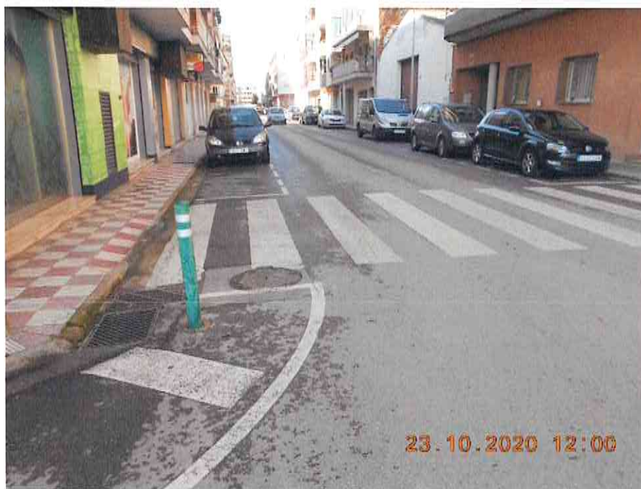
Foto nº 8. Av. Extremadura. Punt final de l'obra.
