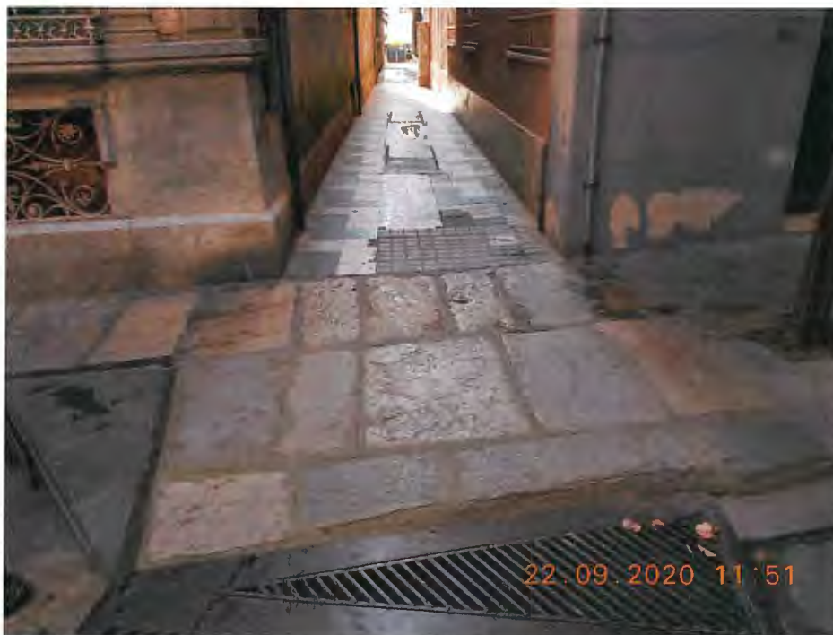
Foto nº 1. Passatge Bonaventura Puig, costat C. Esperança. Punt d'inici de l'obra.
