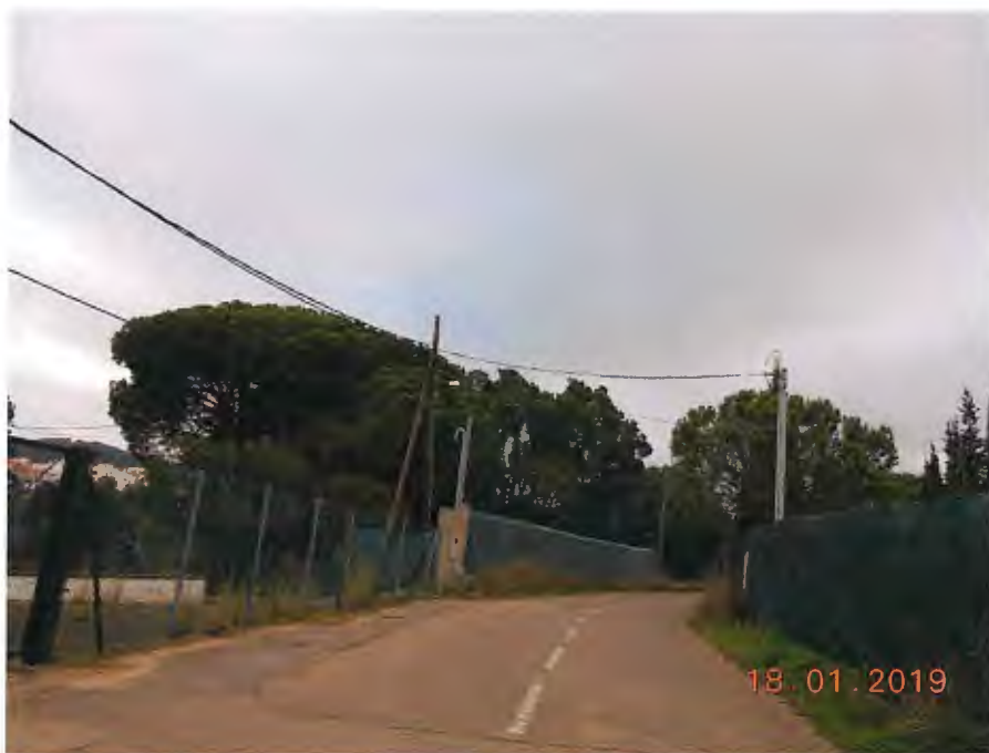
Foto nº 1. Carrer Valldolig. Sortida de la caseta de la impulsió. Punt d'inici de l'obra.
