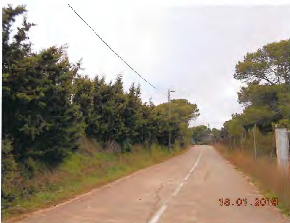
Foto nº 5. Carrer Valldolig. Tram del traçat.
