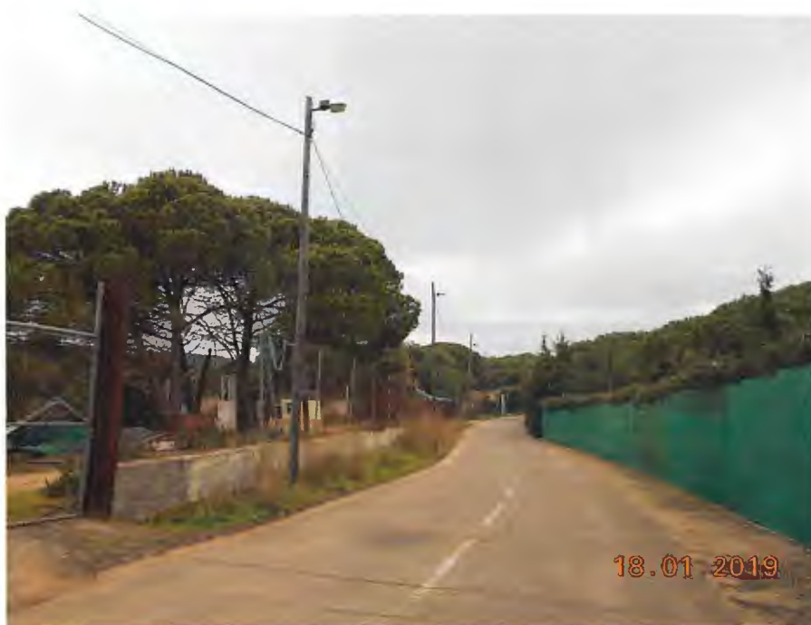
Foto nº 3. Carrer Valldolig. Tram del traçat.
