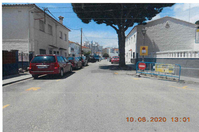
Foto nº 4. Carrer Vescomptes de Cabrera. Vista general. Senyalització de la zona d'obres.
