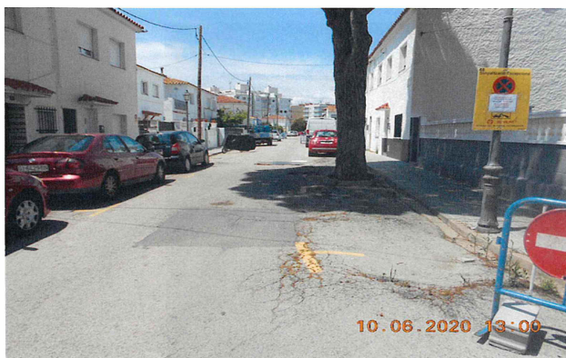
Foto nº 3. Carrer Vescomptes de Cabrera. Vista general. Senyalització de la zona d'obres.
