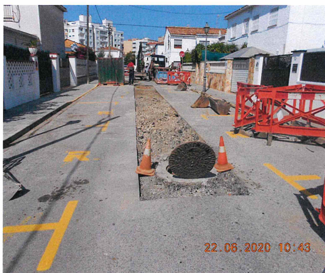
Foto nº 5. Carrer Vescomptes de Cabrera. Obra actual. Rasa xarxa de claveguera en direcció al carrer Francesc Macià.
