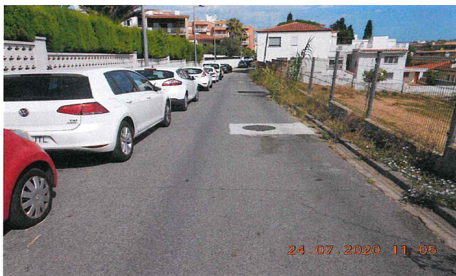
Foto nº 2. Carrer Gironès. Tram obres.
