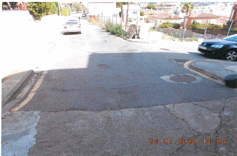
Foto nº 1. Carrer Gironès xamfrà carrer Priorat. Punt inici de les obres.
