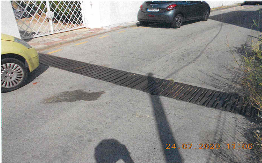
Foto nº 3. Carrer Gironès. Reixa interceptora a substituir.
