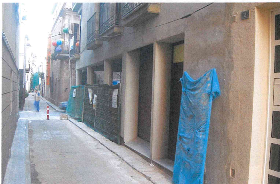
Foto nº 2. Tram del traçat. C.Or.
