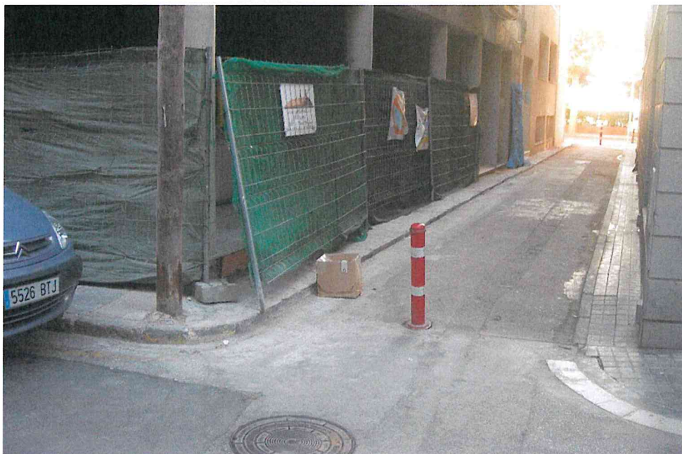
Foto nº 1. Punt de connexió amb el pou de clavegueram del C. Or amb C. Roig i Jalpí.
