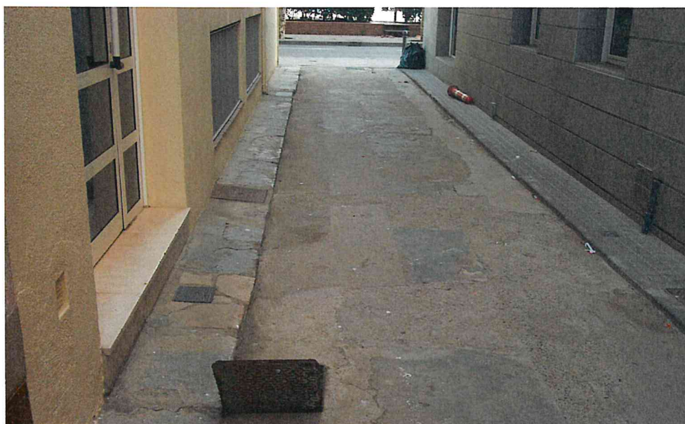
Foto nº 4. Tram del traçat. C. Or.
