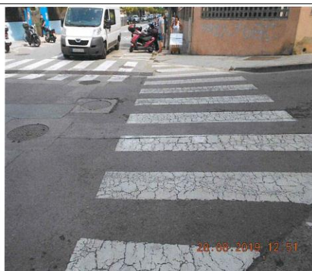
Foto nº 1. Carrer Mas Palou. Punt de confluència i connexió amb Av. Joan Carles I. Tapes existents dels serveis a renovar.
