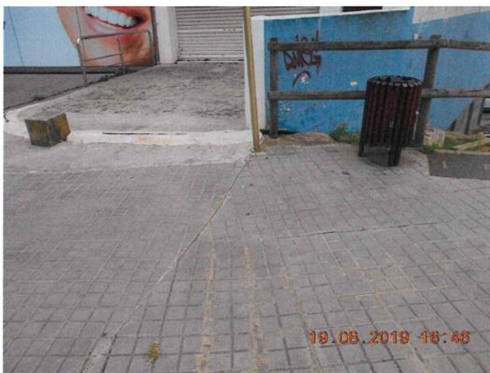
Foto nº 6. C. Anselm Clavé. Inici de la cuneta. Canvi material de la canonada.
