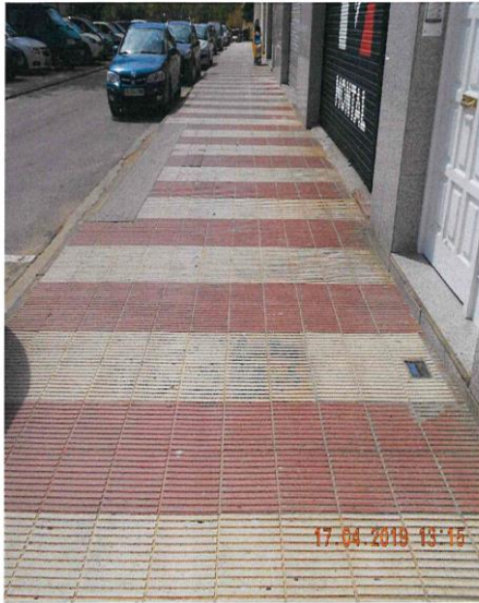
Foto nº 9. Plaça Onze de Setembre. Tram del traçat.
