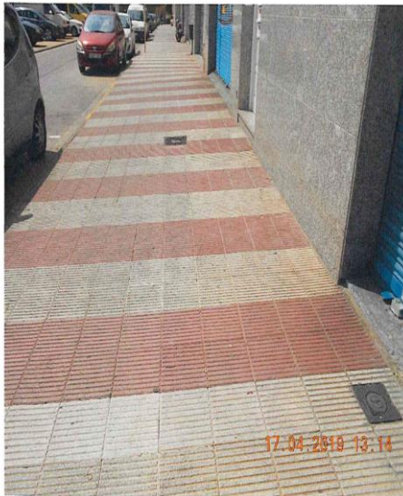
Foto nº 11. Plaça Onze de Setembre. Tram del traçat.
