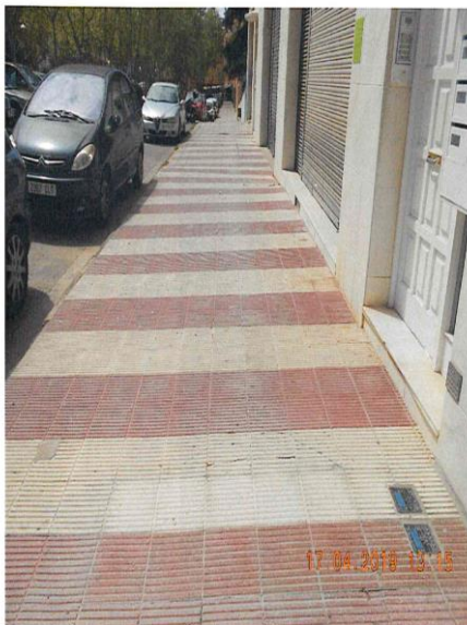
Foto nº 7. Plaça Onze de Setembre. Tram del traçat.
