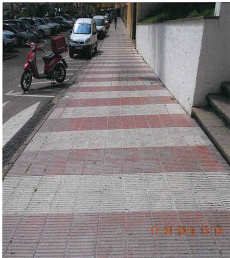
Foto nº 5. Plaça Onze de Setembre. Tram del traçat.
