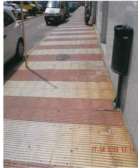
Foto nº 10. Plaça Onze de Setembre. Tram del traçat.
