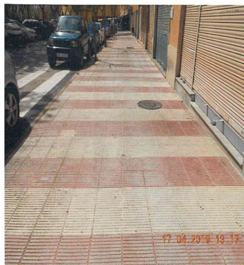
Foto nº 4. Plaça Onze de Setembre. Tram del traçat.
