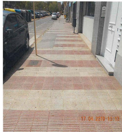
Foto nº 12. Plaça Onze de Setembre. Tram del traçat.
