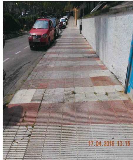
Foto nº 6. Plaça Onze de Setembre. Tram del traçat.
