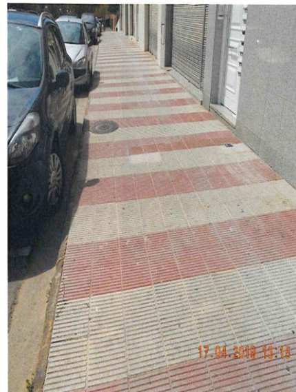
Foto nº 8. Plaça Onze de Setembre. Tram del traçat.
