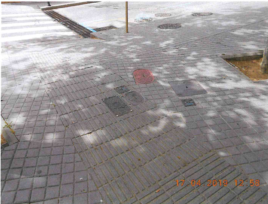
Foto nº 1. Plaça Onze de Setembre. Punt inici dels treballs.
