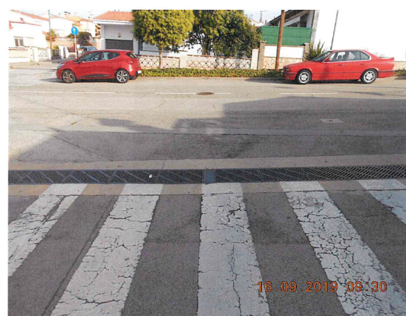
Foto nº 6. Carrer Salvador Dalí. Punt de connexió amb C. Greco.
