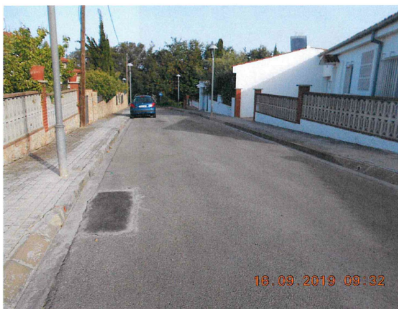
Foto nº 10. Carrer Josep Llimona. Tram del traçat.
