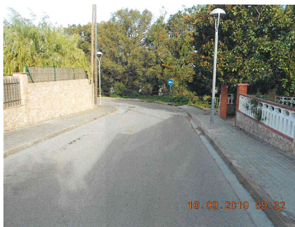
Foto nº 11. Carrer Josep Llimona. Tram del traçat.
