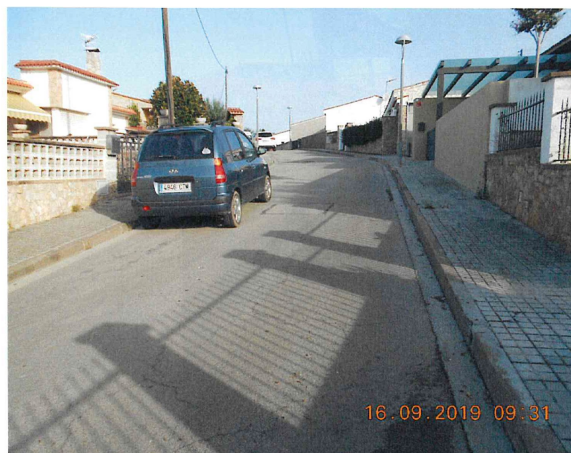
Foto nº 8. Carrer Josep Llimona. Tram del traçat.
