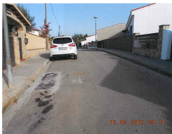
Foto nº 9. Carrer Josep Llimona. Tram del traçat.
