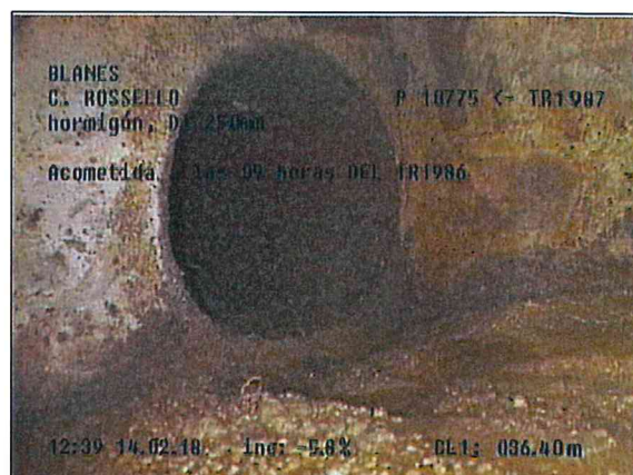
Fotografía: 29a, N° Video: 0032, 00:11:41 36,4m, Acometida a las 09 horas DEL TR1986
