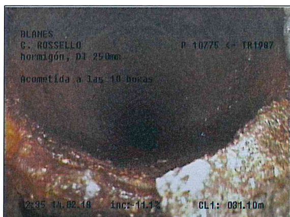
Fotografía: 25b, Nº Video: 0032, 00:09:34 31,1m, Acometida a las 10 horas
