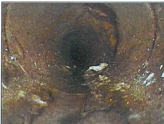
Fotografía: 9a, Nº Video: 0032, 00:00:39 2,4m, Acometida a las 03 horas
