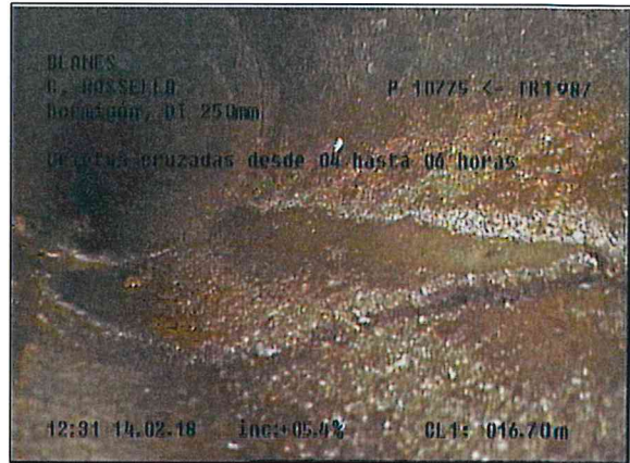
Fotografía: 20b, Nº Video: 0032, 00:06:17 16,7m, Grietas cruzadas desde 04 hasta 06 horas
