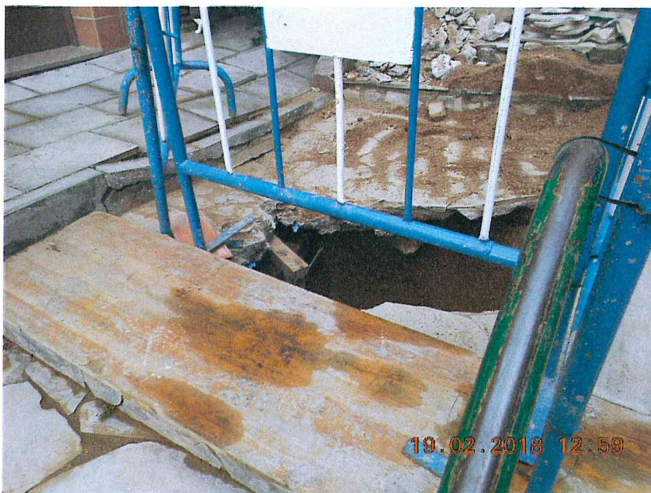
Foto nº 10. Enfonsament de la xarxa de clavegueram i paviment circundant.
