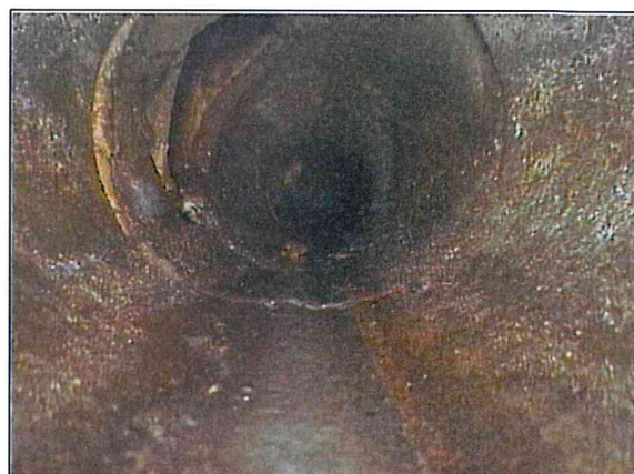
Fotografía: 25a, Nº Video: 0032, 00:09:34 31,1m, Acometida a las 10 horas
