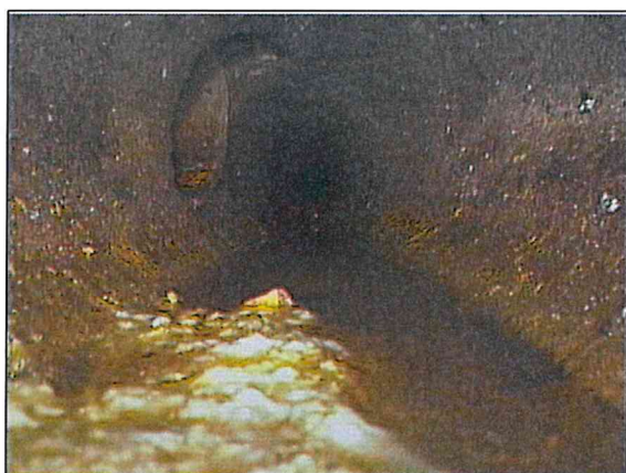
Fotografía: 16a, N° Video: 0032, 00:04:17 12,4m, Acometida desde 09 hasta 10 horas
