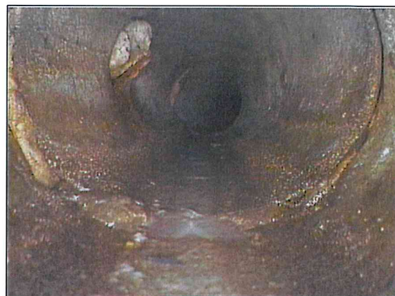
Fotografía: 27a, Nº Video: 0032, 00:10:20 32,2m, Acometida a las 10 horas
