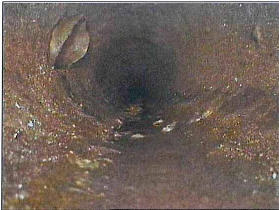
Fotografía: 14a, Nº Video: 0032, 00:03:37 10,3m, Acometida desde 10 hasta 11 horas
