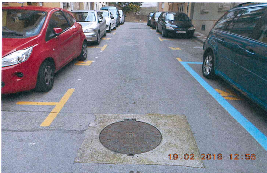
Foto nº 1. Carrer Rosselló direcció carrer Escalles de l'aigua. Punt de connexió entre les noves xarxes i les existents.
