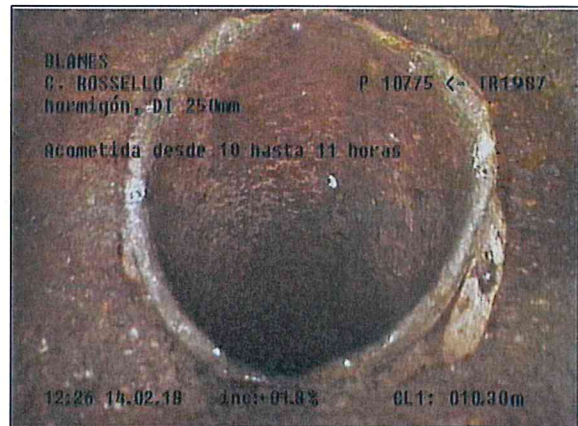
Fotografía: 14b, Nº Video: 0032, 00:03:37 10,3m, Acometida desde 10 hasta 11 horas
