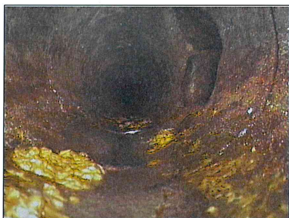
Fotografía: 19a, Nº Video: 0032, 00:05:32 14,2m, Acometida a las 03 horas
