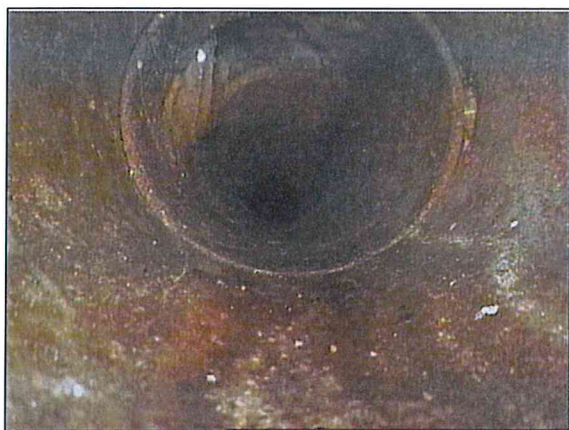
Fotografía: 22a, N° Video: 0032, 00:07:38 23,1m, Acometida a las 10 horas
