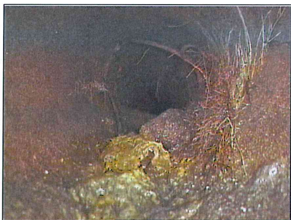
Fotografía: 2a, Nº Video: 0032, 00:00:39 1,9m, Obstáculo por raíces interiores desde 12 hasta 12 horas. Reducción de sección ? %
