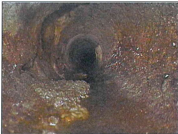
Fotografía: 11a, Nº Video: 0032, 00:02:15 6,5m, Acometida a las 10 horas
