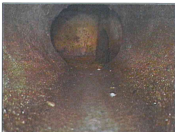
Fotografía: 28a, Nº Video: 0032, 00:11:29 36,4m, Pozo oculto (arqueta) P6726 PROF. 1,20 m
