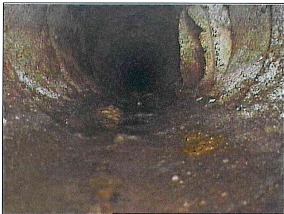
Fotografía: 13a, Nº Video: 0032, 00:02:59 7,2m, Acometida desde 02 hasta 03 horas
