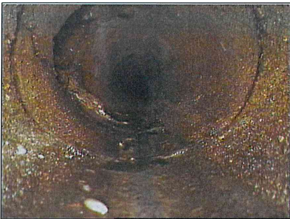
Fotografía: 21a, Nº Video: 0032, 00:06:57 21,2m, Acometida obstruida a las 10 horas
