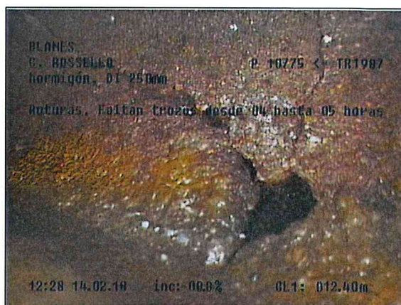
Fotografía: 17b, N° Video: 0032, 00:04:39 12,4m, Roturas. Faltan trozos desde 04 hasta 05 horas
