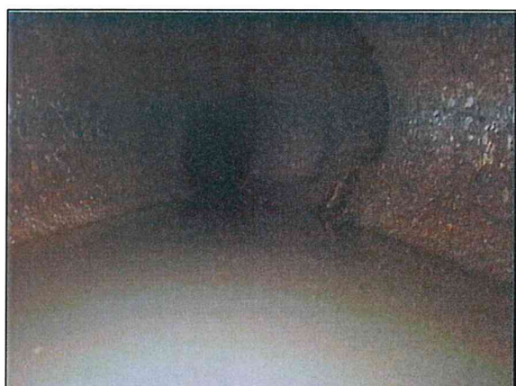
Fotografía: 32a, Nº Video: 0032, 00:01:11 5,1m, Acometida a las 03 horas DEL P6726 PROF. 1,20 m
