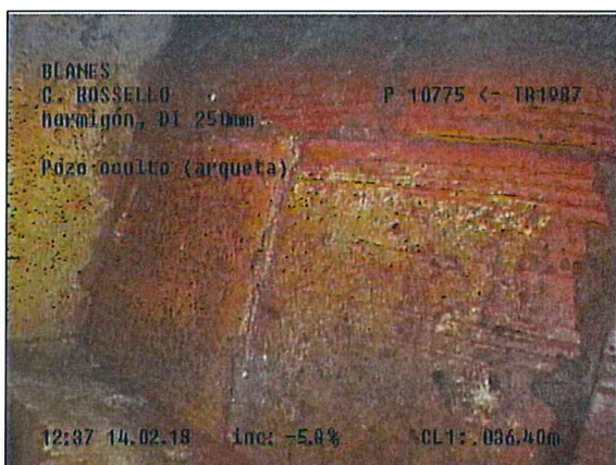
Fotografía: 28b, N° Video: 0032, 00:11:29 36,4m, Pozo oculto (arqueta) P6726 PROF. 1,20 m
