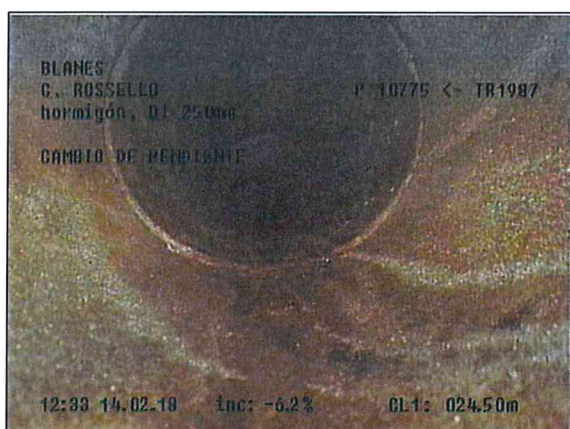
Fotografía: 23a, N° Video: 0032, 00:07:56 24,5m, CAMBIO DE PENDIENTE
