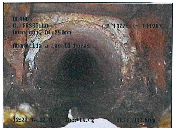
Fotografía: 9b, Nº Video: 0032, 00:00:39 2,4m, Acometida a las 03 horas
