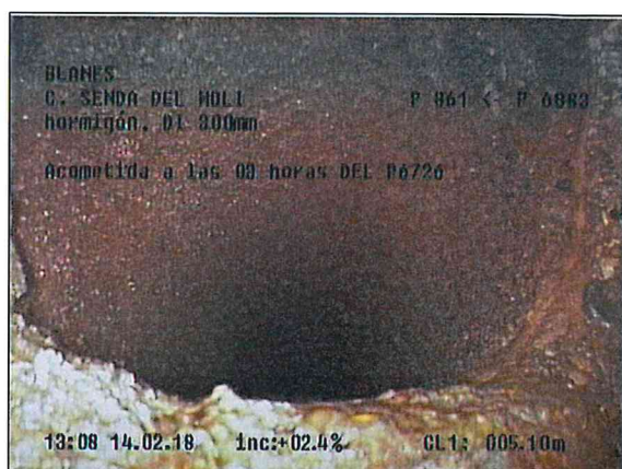
Fotografía: 32b, Nº Video: 0032, 00:01:11 5,1m, Acometida a las 03 horas DEL P6726 PROF. 1,20 m
