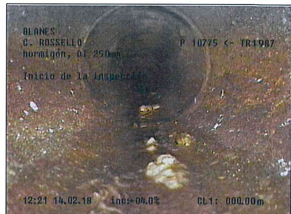
Fotografía: 8b, Nº Video: 0032, 00:00:10 0m, Inicio de la inspección
