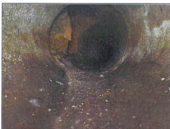
Fotografía: 24a, N° Video: 0032, 00:08:47 29,3m, Acometida desde 09 hasta 10 horas
